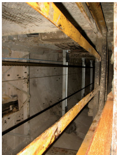
Bild 1. Blick in den Schacht
