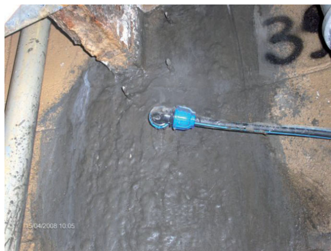
Bild 6. Abgedichtetes Trägerauflager (Fotos/Grafik: KÖSTER BAUCHEMIE)
