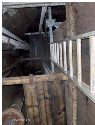
Bild 5. Schacht mit Arbeitsebenen
